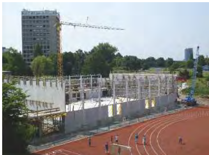
Rohbau der neuen Sporthalle (Juni 2010)
