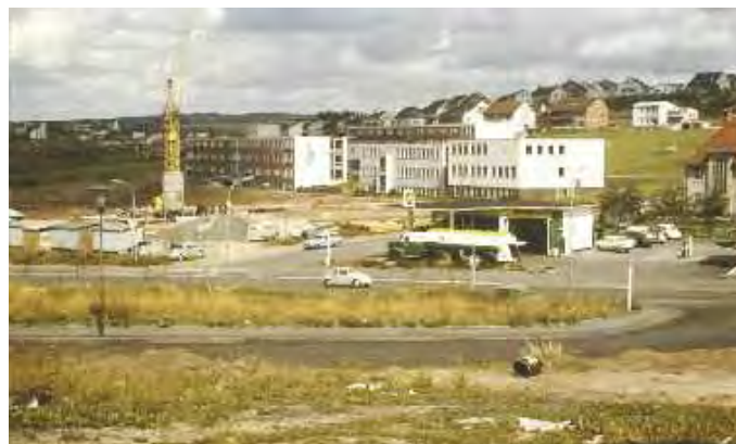
Bau der Turnhalle und der Sportanlagen (1963 - 1965)
