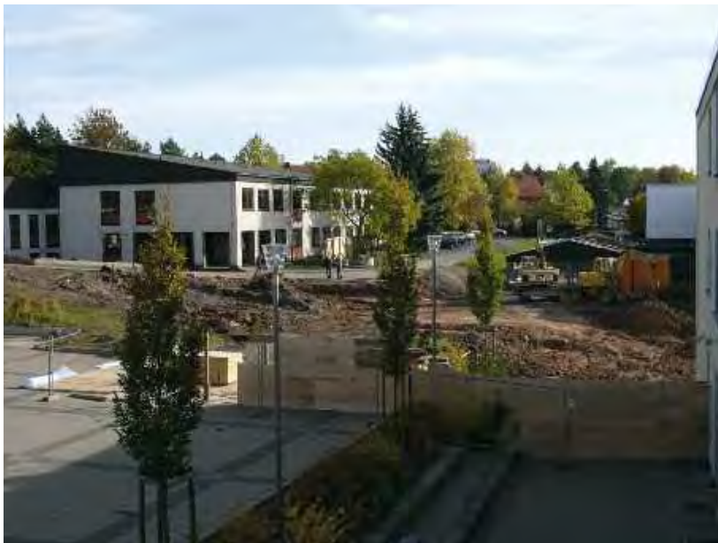
Die neue Aula wird gebaut
