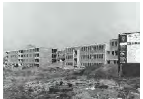
Der Rohbau ist fast fertig
